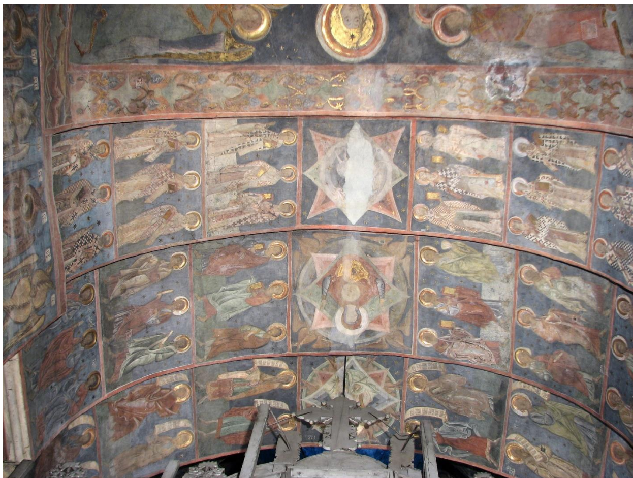
2.21. Neamț. Boltirea traveei de vest a absidei
