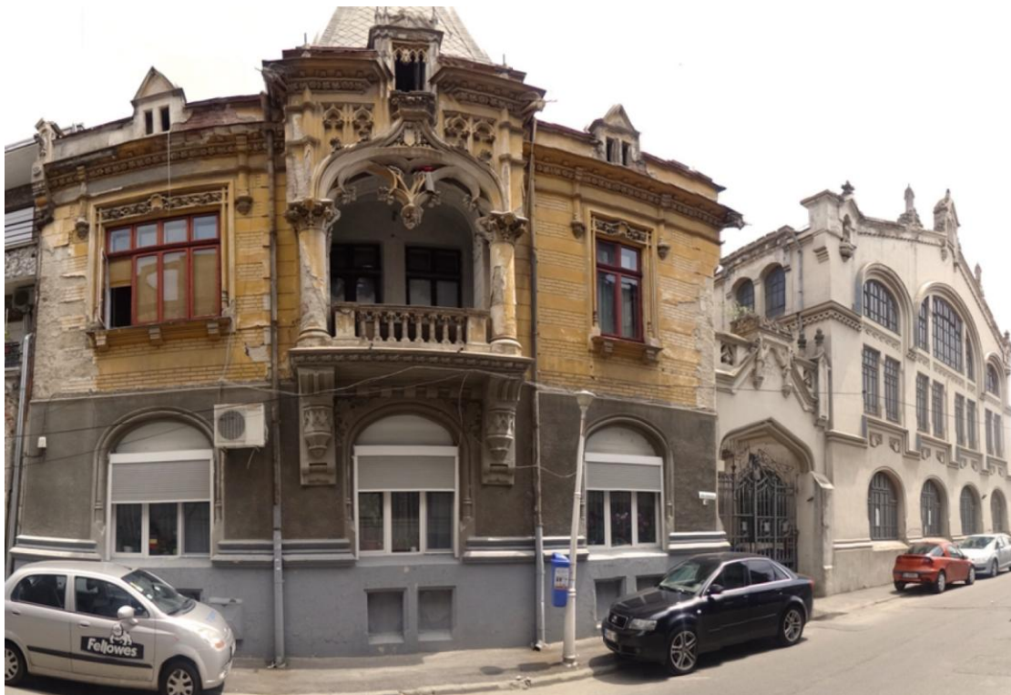
Fig. 4.9. Clădirea fostei fabrici de trăsuri
