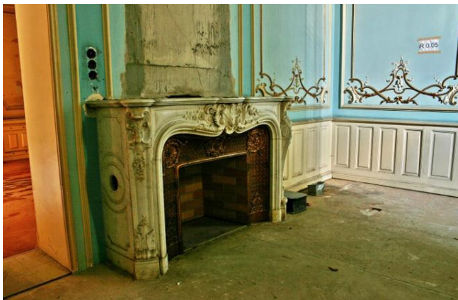
Fig. 4.18. Casa Cesianu - interior
